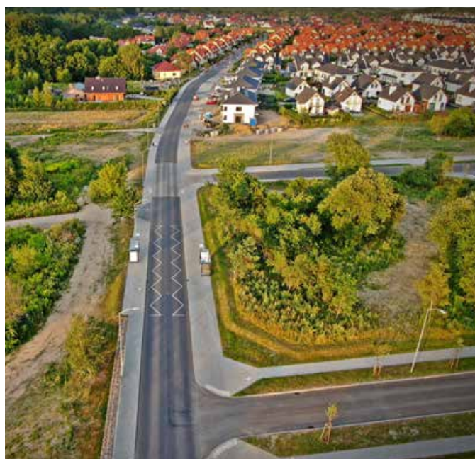
10) Budowa ul. Miodowej (kierunek Gubałówka) - 2 248 268 zł (łącznie nakłady 9 659 194 zł)
